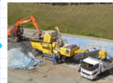
③ 自走式土質改良機混合40m³/h
